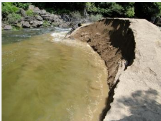
室生ダムにおける土砂供給
