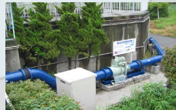
森ヶ崎水再生センター
