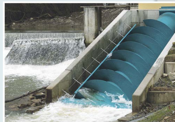
水車発電機設置例
