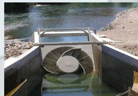
水車発電機据付
