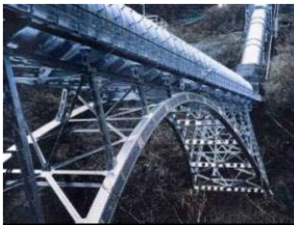
既設水管橋の概観
