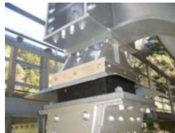
改良後の水圧鉄管支承(免震支承)
