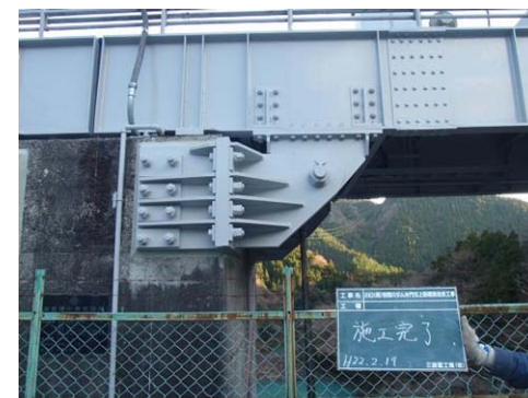
ピン構造部材設置部
