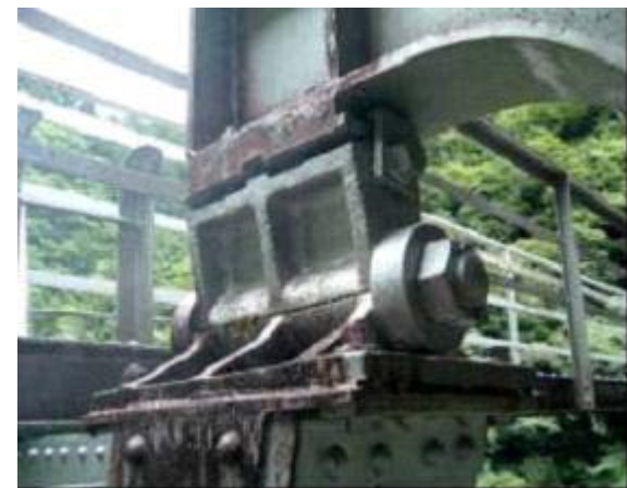
既設の水圧鉄管支承(ロッカ支承)
