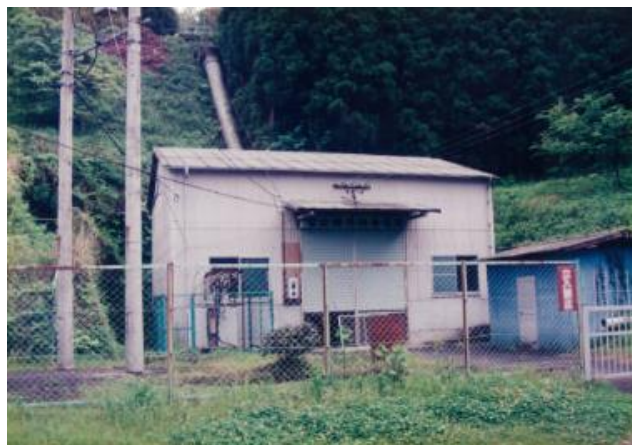
第一発電所：380kW
