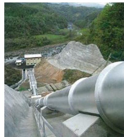
第二発電所：1,500kW
