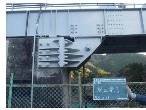
ピン構造部材設置部
