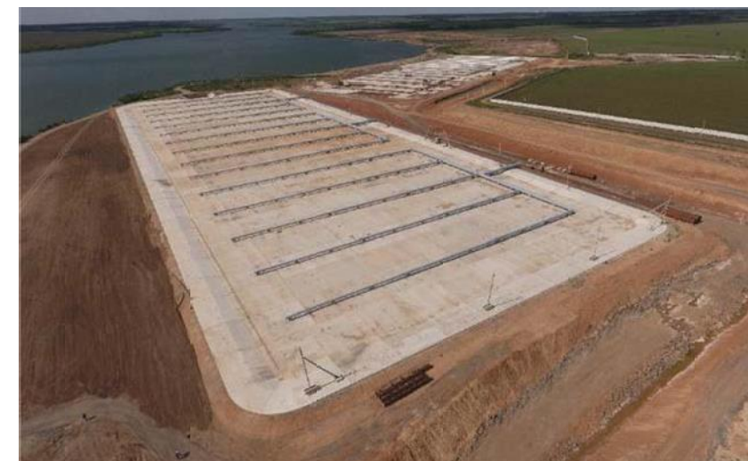
南ウクライナ原子力発電所冷却用の噴水プール
