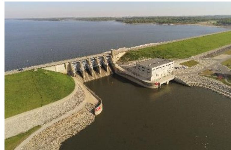
重力式コンクリートダム部直下流に発電所を新設
