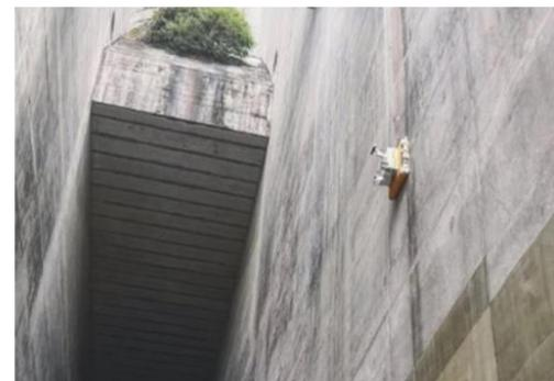
コンクリート水路の検査・計測ロボット
