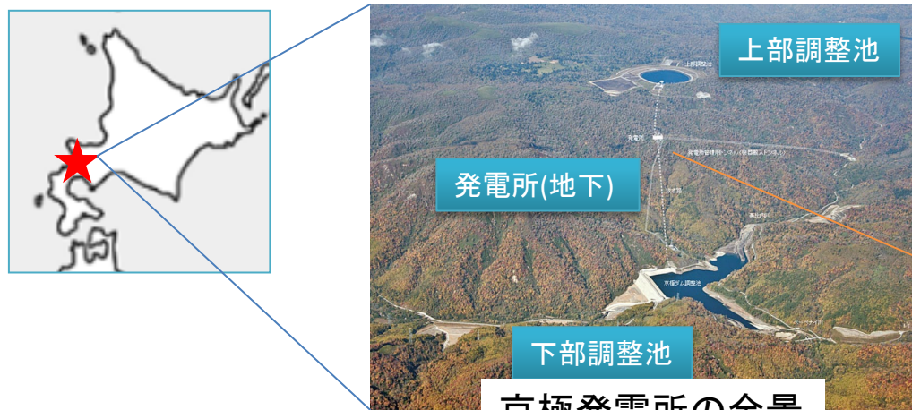
京極発電所の全景
