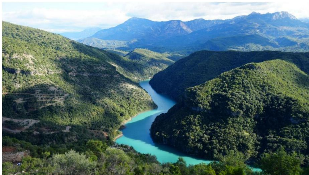
写真1. アンフィロキア揚水発電施設
