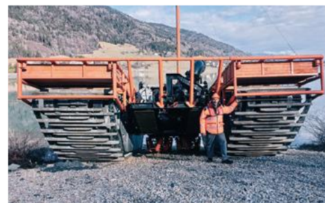
浚渫ロボット(右)と上池 への設置状況(左)
