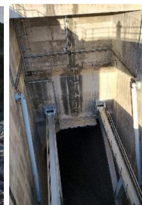
洪水吐ゲート (転流トンネルを流用)
