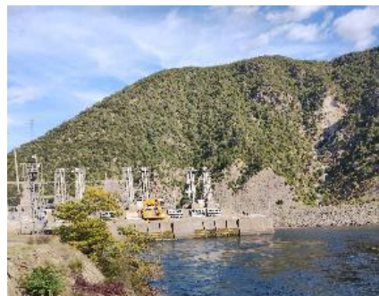
取水口と開閉所
