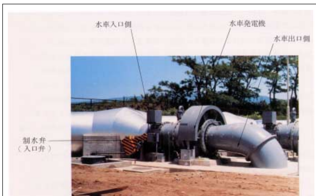
図 2-11-3 一体形水車発電装置外観
