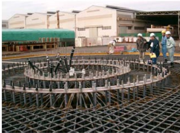
風車建設時の基礎工事
