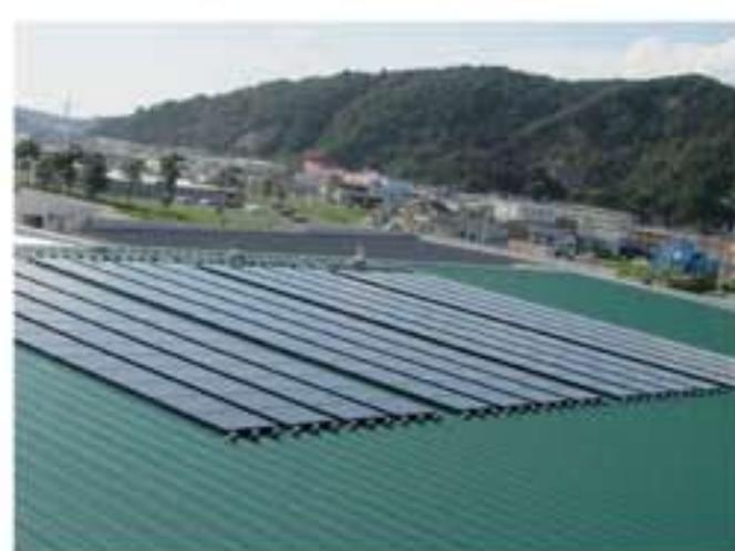
水産加工会社の社屋・加工施設に太陽光発電パネルと大型リチウムイオン蓄電池を組み合わせた太陽光発電システムを設置。「津波避難ビル」として石巻市から認定され、「避難もでき、電気が使える会社」として地域貢献につながっている。
