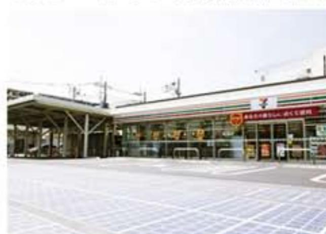
セブン-イレブン・ジャパンの「ひとと環境にやさしい店舗」の取り組みにおける「環境負荷の低減」最先進店舗。駐車場に高透過性・高耐久性のあるコーティングを施した仮社製の路面型太陽光発電設備201.6m<sup>2</sup>敷設。また風力、太陽光発電一体型のサインポール、カーポート上にも太陽光発電システムを設置。蓄電池については、車のリユースバッテリーを活用したものと産業用の大容量蓄電池の2種類を設置するなど、多くの新技術を採用し使用電力の約46%<sup>※1</sup>を「CO<sub>2</sub>排出ゼロ」の再生可能エネルギーで賄っている。
