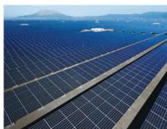
東京ドーム約27個分、およそ127万m<sup>2</sup>の造船所用地に、太陽電池パネル29万枚を設置。発電能力は一般家庭の2万2千世帯分に相当し、鹿児島県の消費電力の約2.2%を賄っている。見学施設としてソーラー科学館を併設し、国内外から多くの来場者を迎えるなど、日本のメガソーラーの認知向上に貢献している。
