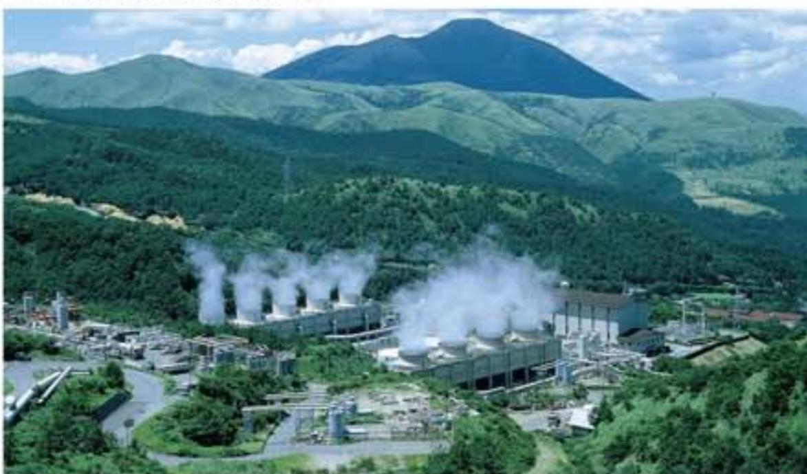
八丁原発電所は、風光明媚な阿蘇くじゅう国立公園特別地域の一画にある国内最大規模の地熱発電所。発電に利用できない還元热水の蒸気を利用して温泉水を作り、一般家庭や旅館等に供給している。
